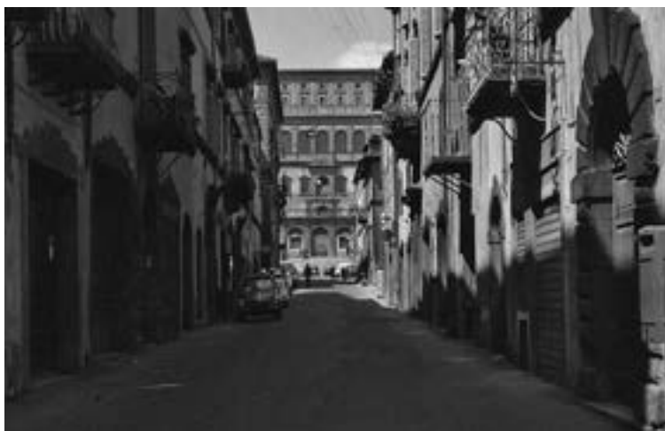
Fig. 1. Caprarola, Palazzo Farnese visto dal rettifilo progettato dal Vignola in funzione della visione assiale della facciata d'ingresso (fotografia dell'autore dei primi anni Settanta del secolo scorso).
