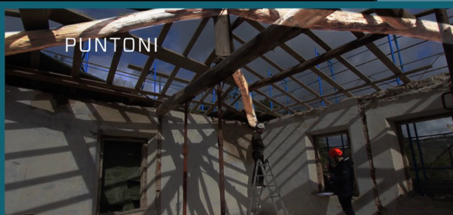
5: Nella puntata 11 la descrizione delle strutture a sostegno della copertura, ricche di nomenclature tecniche, ha suggerito di evidenziare sulle immagini le diciture corrispondenti alla voce narrante.
