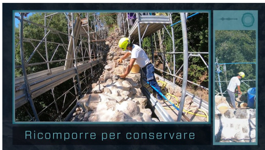
2: Spezzone del videodiario n. 7. Oltre alla rimozione della vegetazione infestante, all'erogazione di biocida e alla pulitura in profondità della muratura, la puntata illustra anche la sigillatura e il trattamento di finitura superficiale delle creste.
