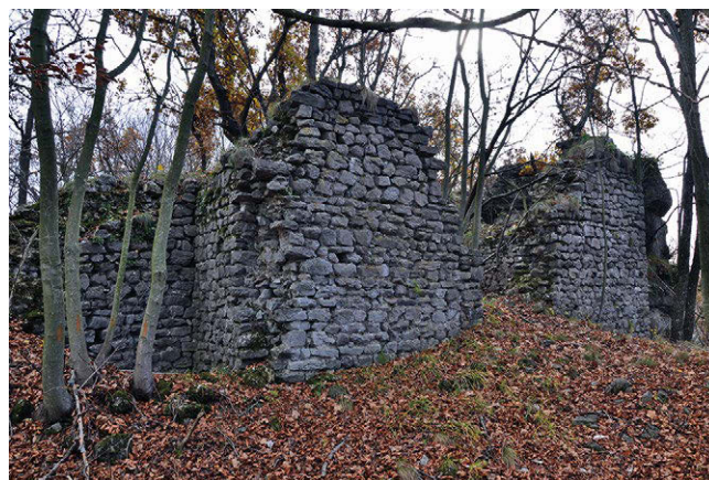
fig. 7 – La torre sud - uno degli elementi più caratterizzanti il sito, e sicuramente da valorizzare mediante la pannellistica - prima delle operazioni di pulitura (foto: R. Rudiero)
