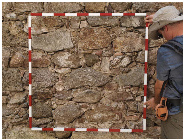
fig. 15 – Misurazione e analisi delle strutture murarie in elevato del castello di Nucetto (foto: M. Villata).
