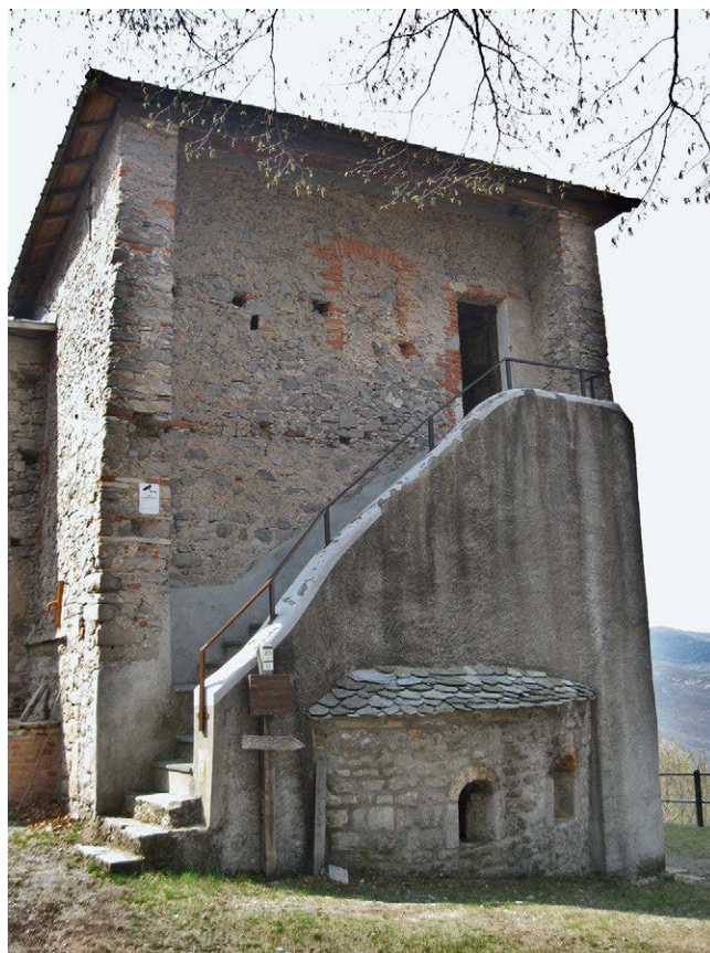
fig. 3 – Abside della cappella titolata ai santi Quirico e Giulitta, inglobata all'interno del narcece della chiesa successiva e di più grandi dimensioni (foto: R. Rudiero).
