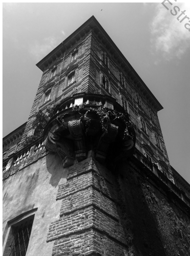
Fig. 2. Agliè, Castello (Amedeo di Castellamonte, 1646-56), veduta delle terrazze (2016, fotografia dell'autore).
