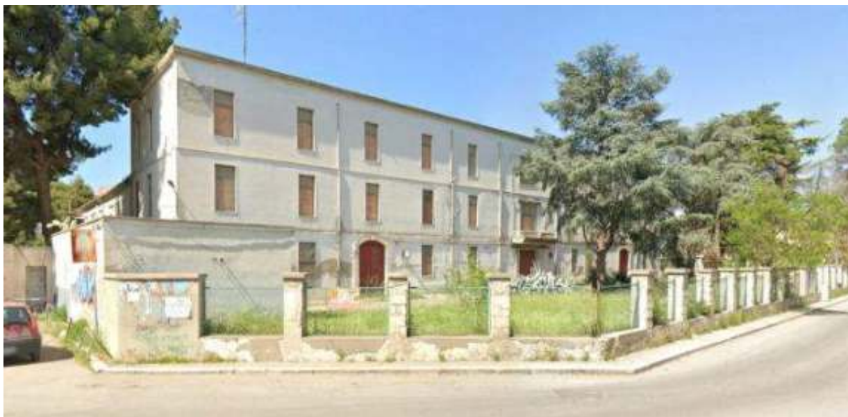
Fig. 2. Prospetto dell'Ex-Distretto Militare da Via Fuiani (immagine da Google Earth).
