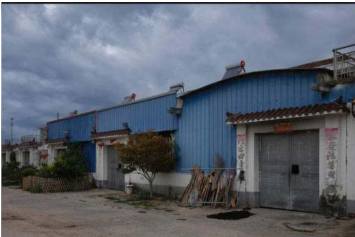
Fig. 5. Case-bottega e sovrapposizioni informali: ampliamenti spontanei e adattamenti continui ridefiniscono gli spazi di lavoro e abitazione, novembre 2024 (foto dell'autore).
