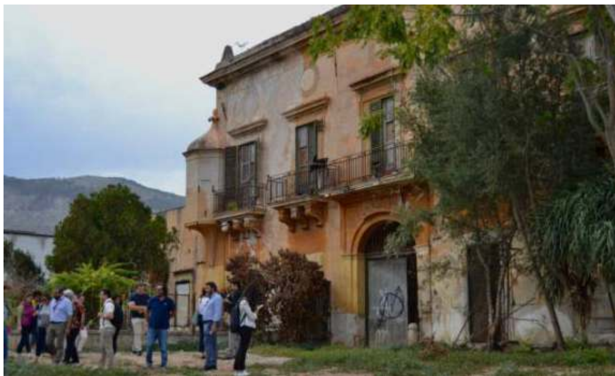
Fig. 3. Palermo, area di Villa Maltese. Vista del prospetto dell'edificio storico, che testimonia il valore patrimoniale del complesso e il suo ruolo potenziale come elemento catalizzatore di processi di rigenerazione e riattivazione dello spazio marginale circostante (foto F. R. Bruno).
