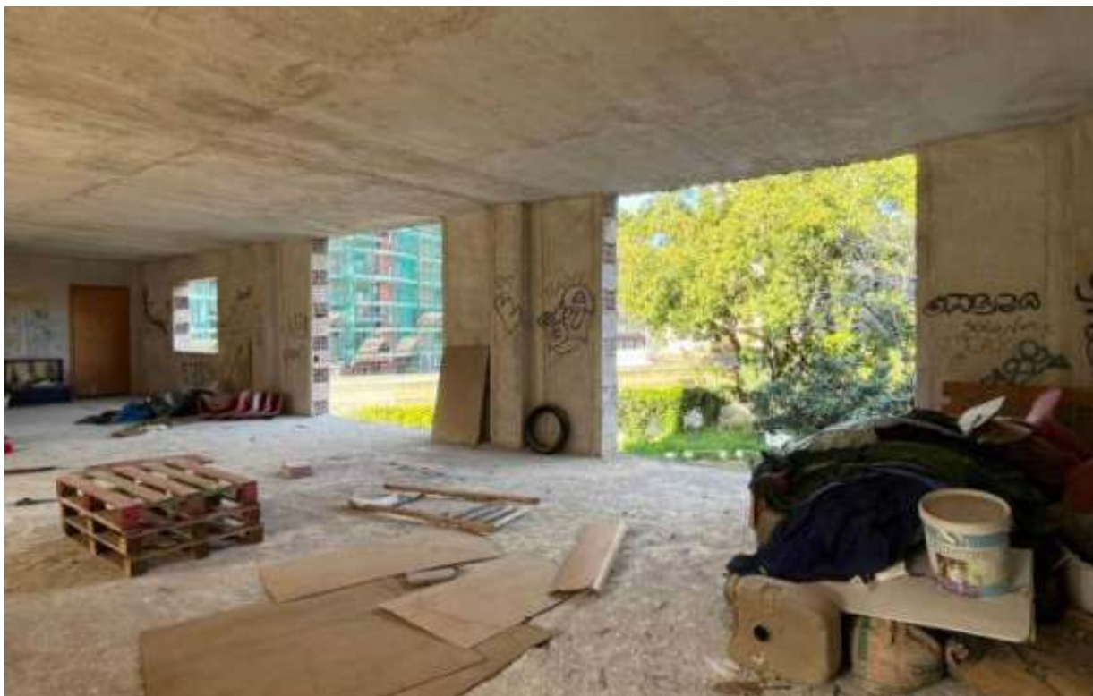
Fig. 4. Palermo, edificio incompiuto di Via Pietratagliata Santa Margherita, interno del primo piano (foto dell'autore).
