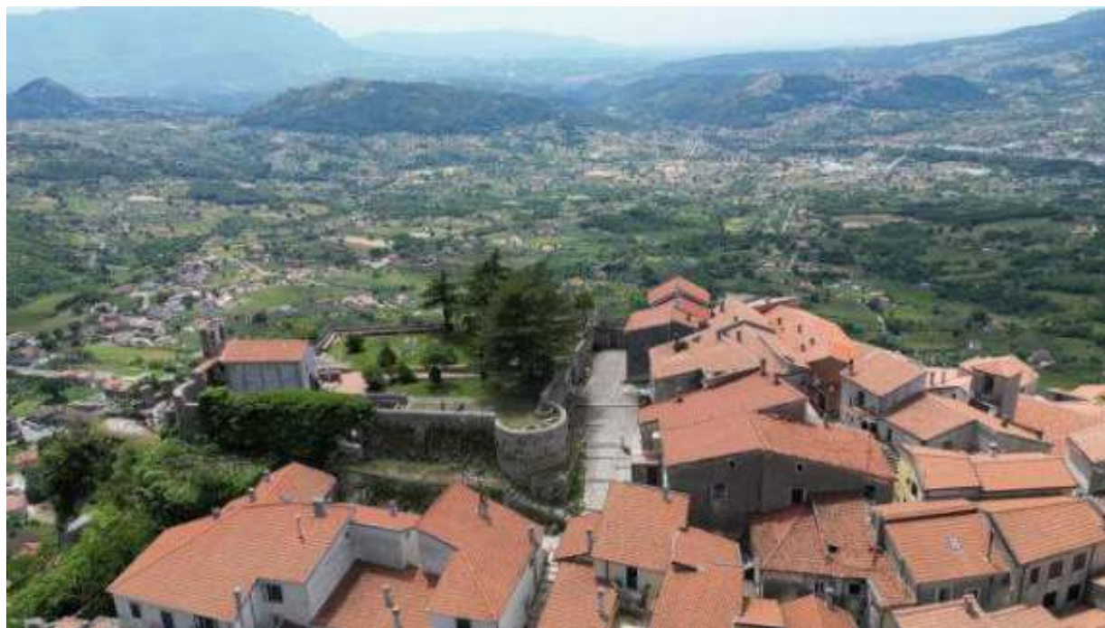
Fig. 6. Il castello di Colliano all'interno dell'impianto urbano che, nel tempo, si è sviluppato nell'area circostante. Sullo sfondo è possibile riconoscere i Monti Alburni e la città di Oliveto Citra e, in pianura, il corso del fiume Sele (foto dell'autore).
