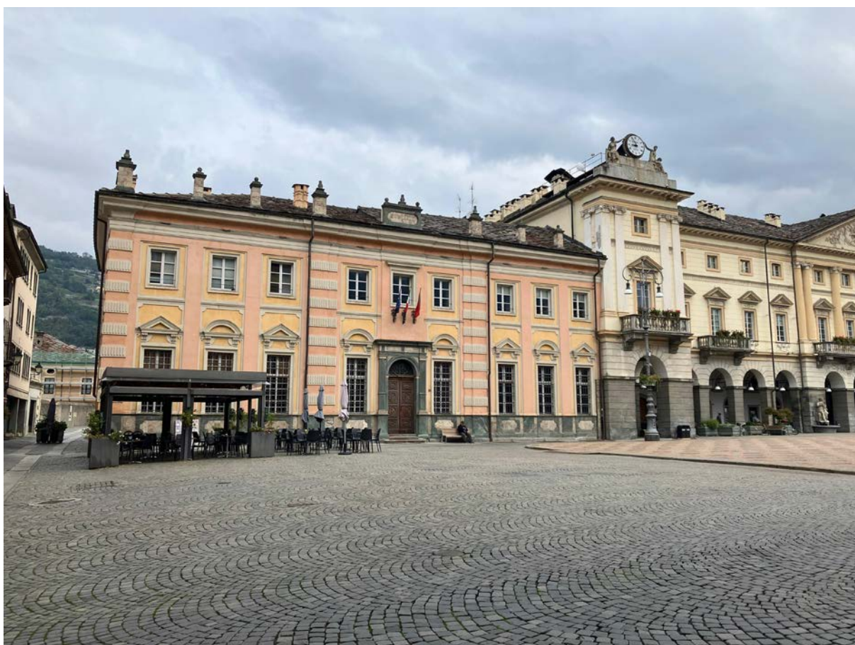
3. Aosta. Edificio adiacente al palazzo comunale, 2024. Foto dell'A.
