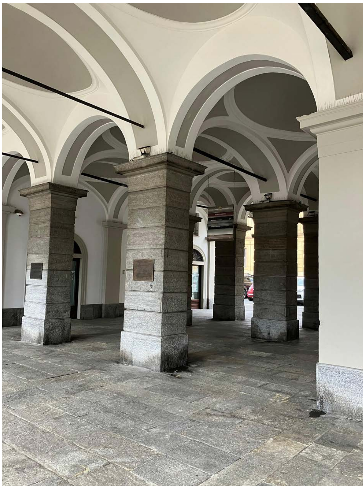
7. Aosta. Passaggio coperto di collegamento a piazza Émile Chanoux, dettaglio del portico, 2024. Foto dell'A.
