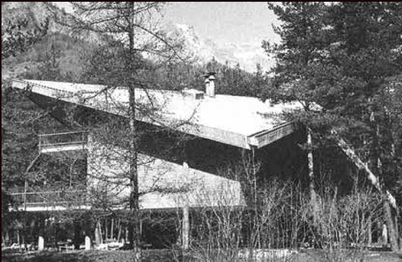
Vista esterna con in primo piano la copertura ondulata grigio chiaro in cemento-amianto (da «AC Revue Internationale d'amiante-ciment», n. 78, aprile 1975, p. 30)
