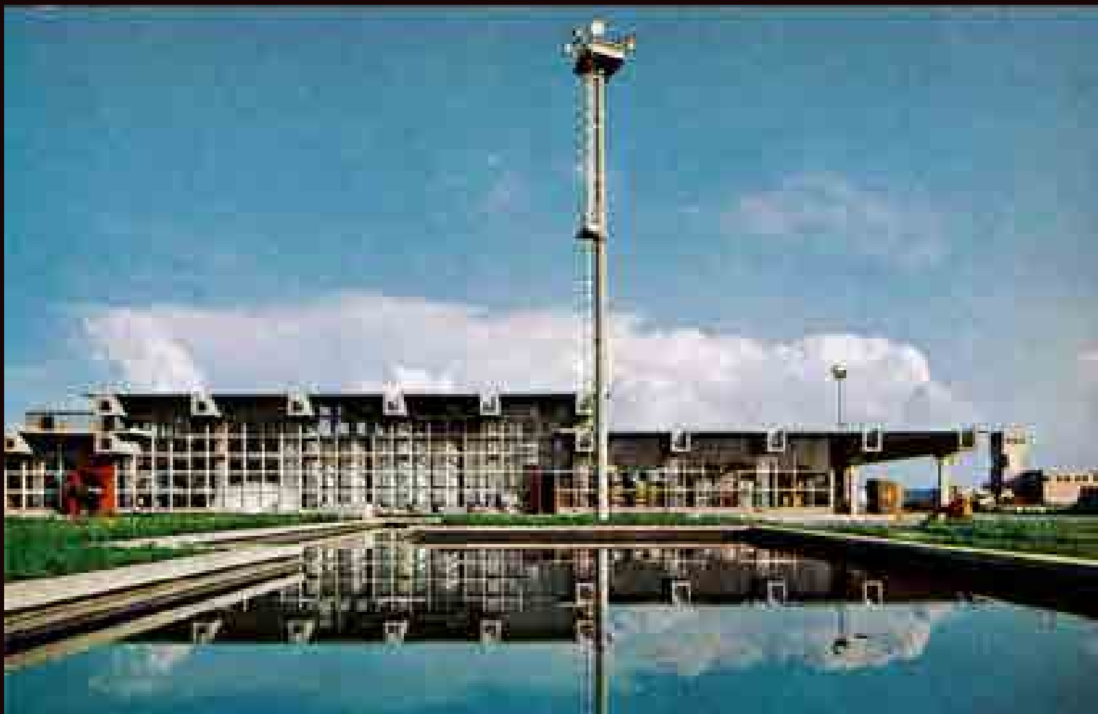
Veduta esterna dello stabilimento con in primo piano la vasca d'acqua (da «L'architettura. Cronache e storia», n. 166, agosto 1969, p. 217, foto Ugo Mulas)
