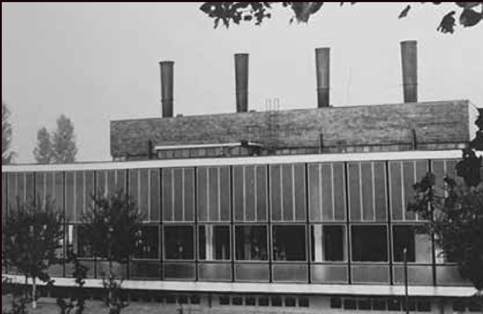
La centrale termica (da Nathan Shapira, Hans Von Klier, Perry King, a cura di, Design Process Olivetti 1908-1978 , Olivetti, Milano 1979, p. 49)
