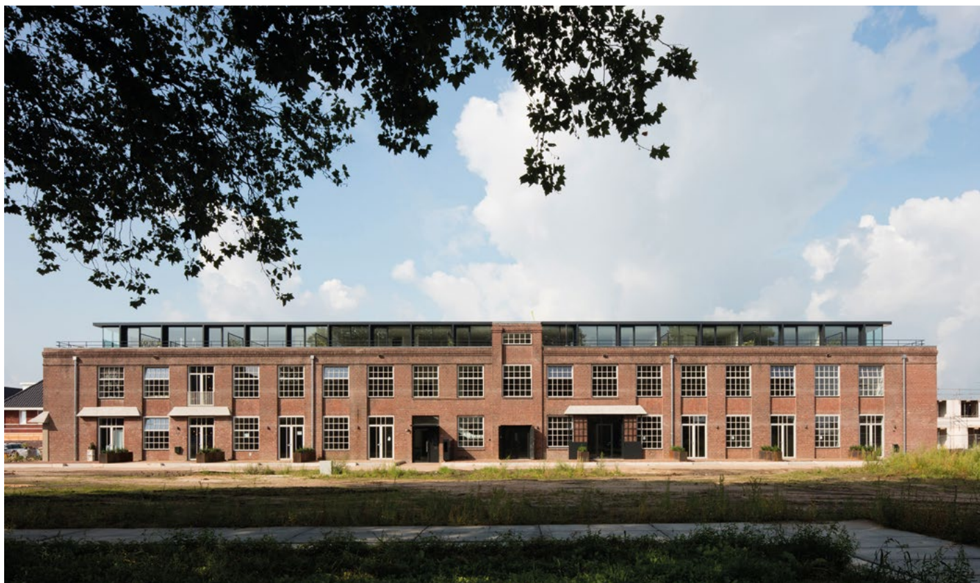
Fig. 4 – De Lakfabriek, Oisterwijk, 2018, progettista Wenink Holtkamp Architecten (ph. T. van de Velde, www.tvdv.be , tratta da Roofscape Design cit.).
