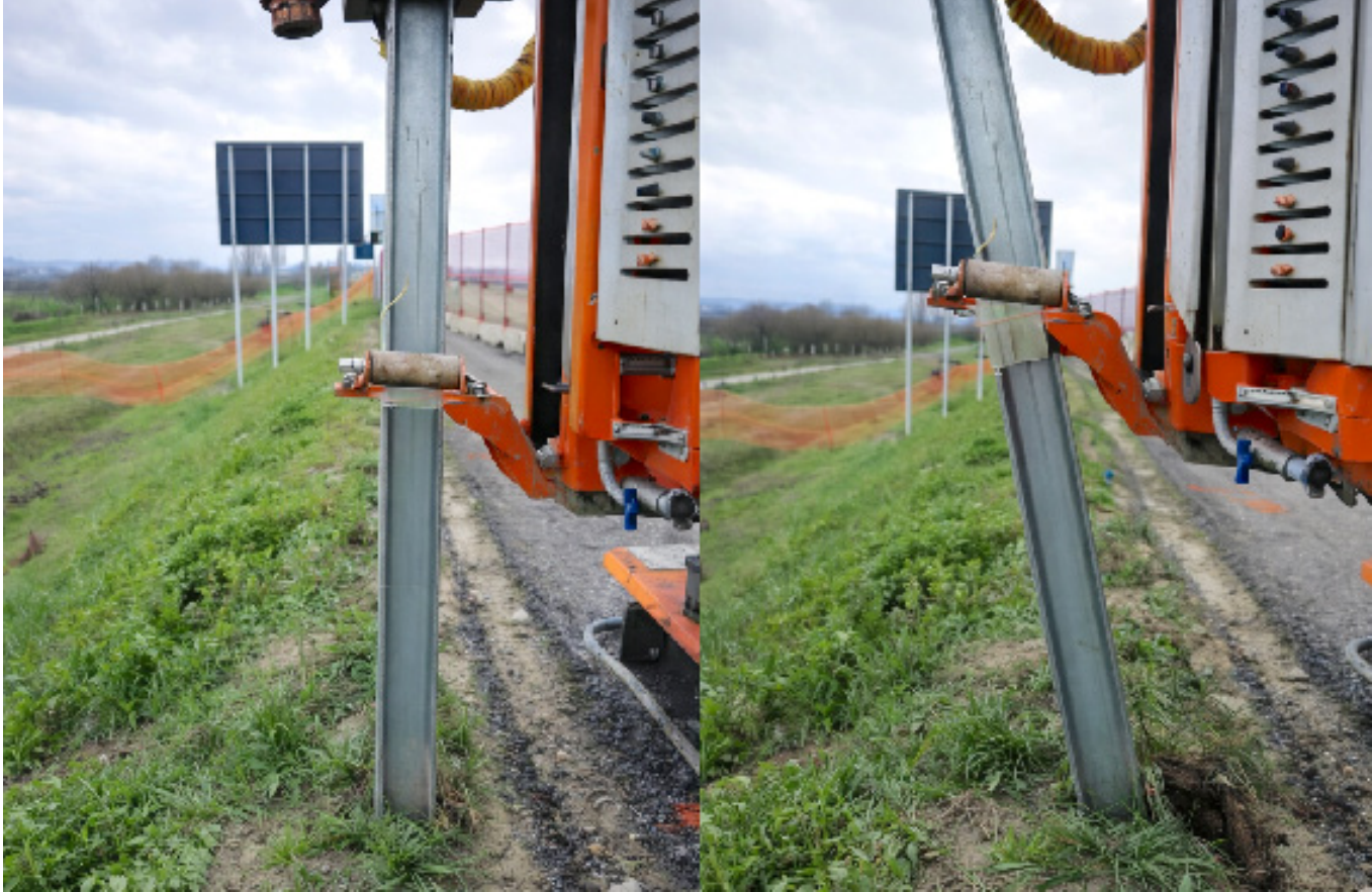
Figura 4: Immagini di una prova di push quasi-statica eseguita in opera su profilato HEB120 per la verifica dello stato di consistenza del terreno.
