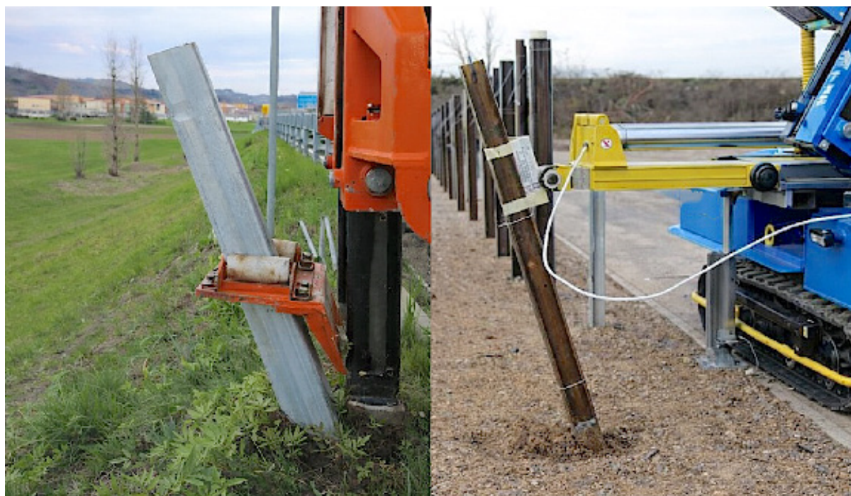
Figura 1. Prova di carico push metodo quasi statico su profilato HEB120 (immagine di sinistra prova in sito - immagine di destra in campo prova).
