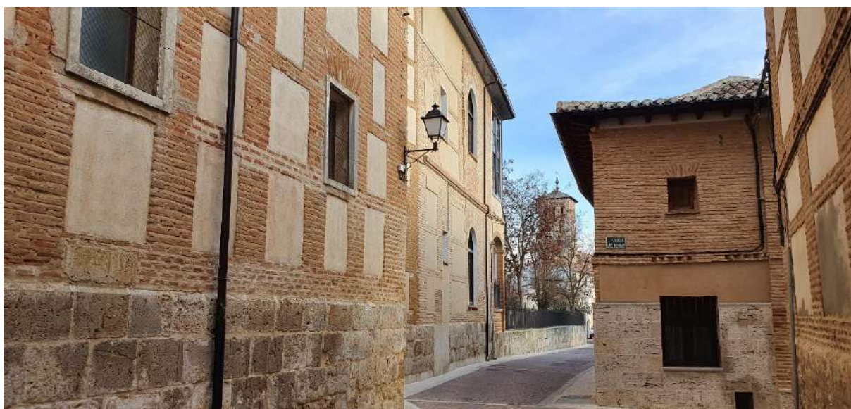
Calle Santa María en Paredes de Nava, Palencia, España, definida por el lateral de Convento de San Francisco y Convento de la Hnas. Brígidas (técnica mixta de tapia encadenada con ladrillo macizo y morteros de tierra en juntas, sobre basamento de piedra) y vivienda particular rehabilitada (foto de Pilar Díez)
