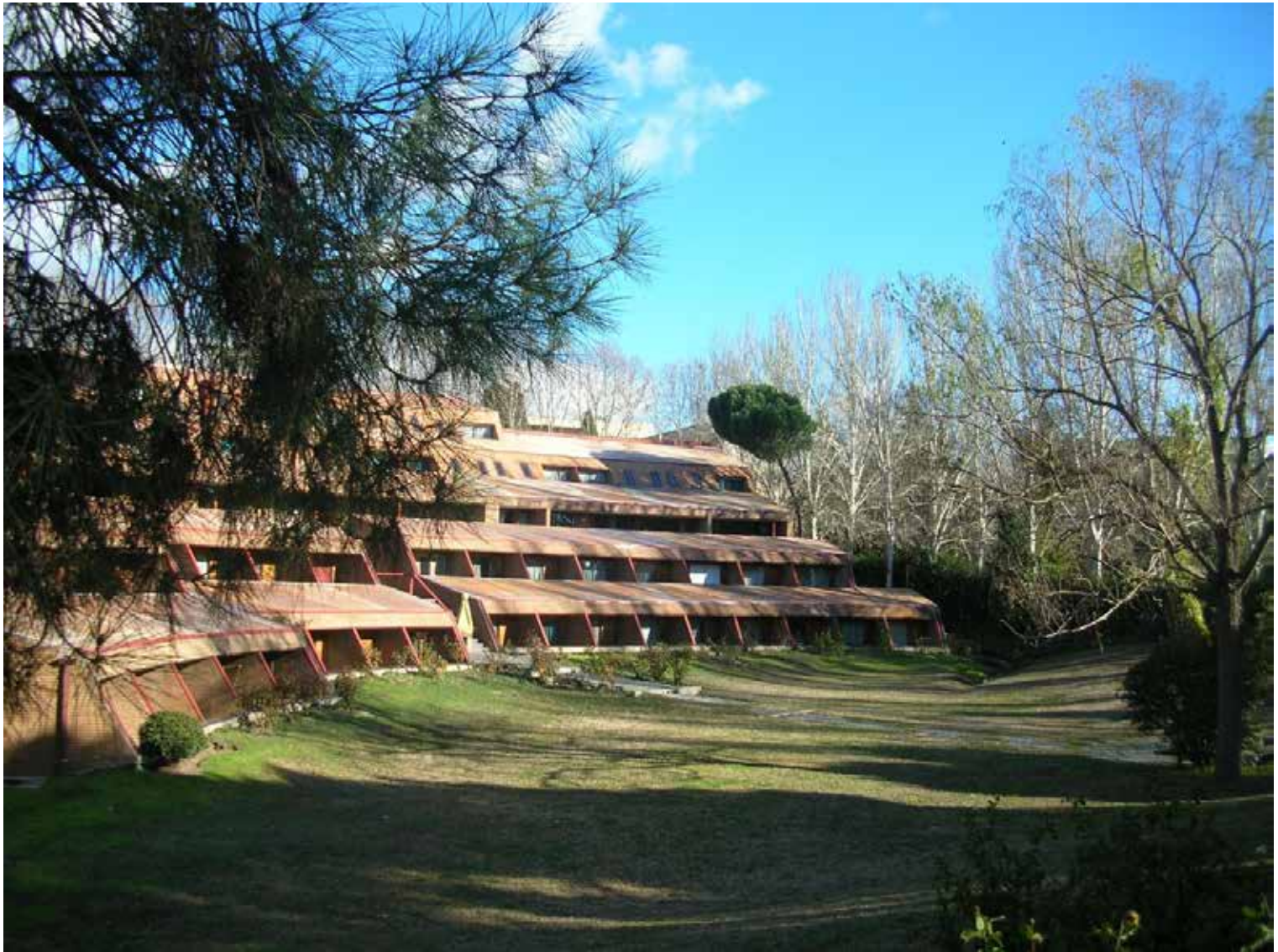
Fig. 14 Colegio Mayor Argentino en Madrid, fachada hacia la calle y hacia el patio interior. Fuente: Eduardo Maestripieri
