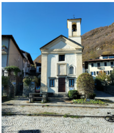
Figura 2.7. Chiesa di San Tommaso.
