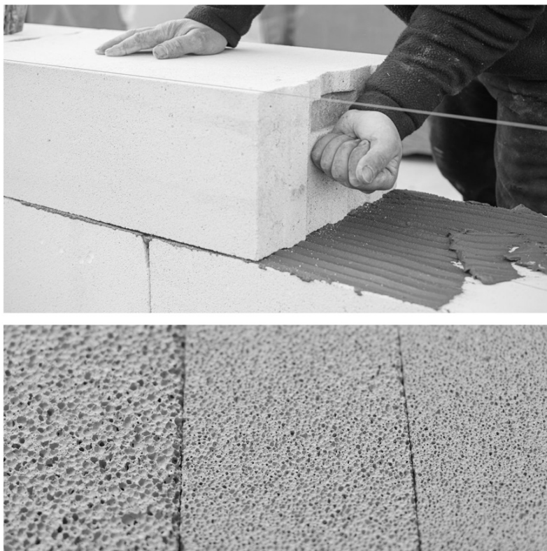
Figura 1. Posa di un blocco in CAA e confronto tra blocchi con porosità differente [Fonte: AsmitA India Reality & Ecotrend].
