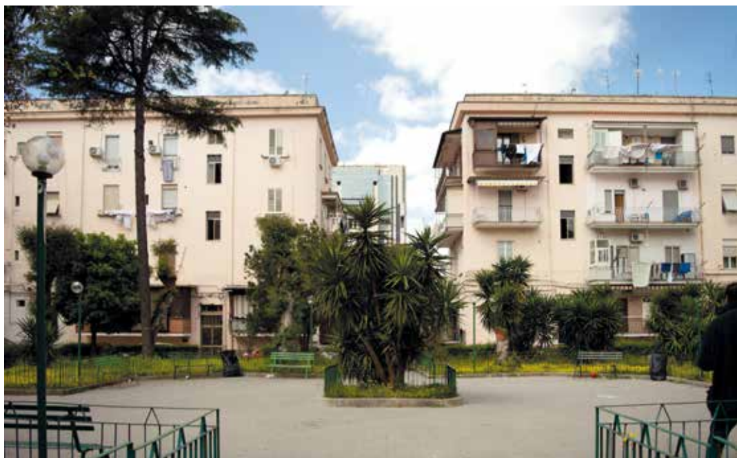
[5] In alto. Interno del quadrante a sud-est.
