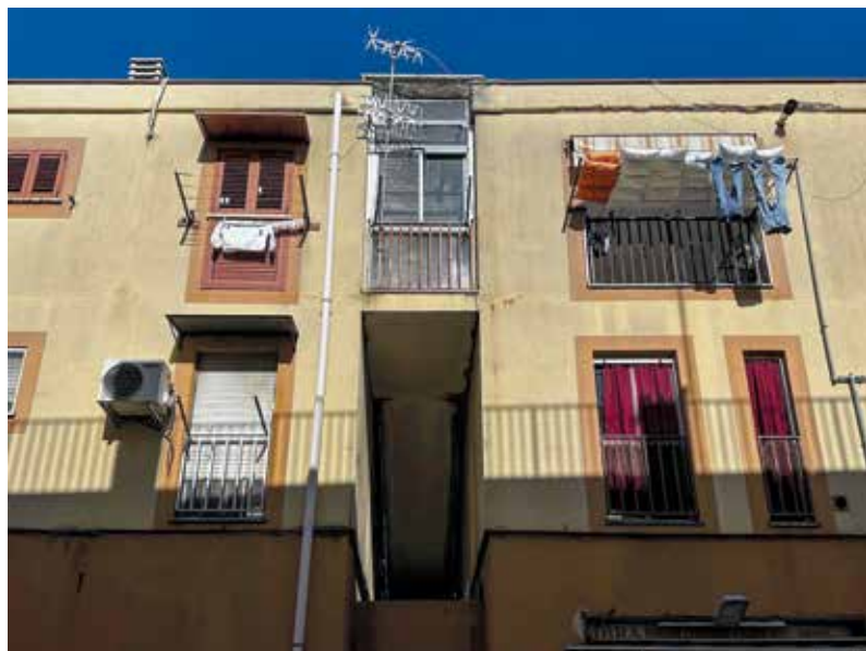
[6] Dettaglio del prospetto su Via Serino.
