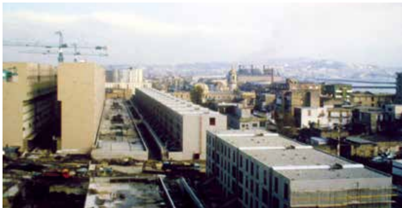
[4] Napoli, il cantiere di edilizia prefabbricata nel comparto di Barra-Pazzigno in una fotografia del 1989.
