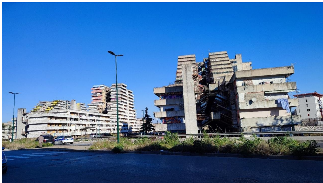
Figura1. Veduta delle Vele di Scampia prima della demolizione (foto dell'autrice, marzo 2024).
