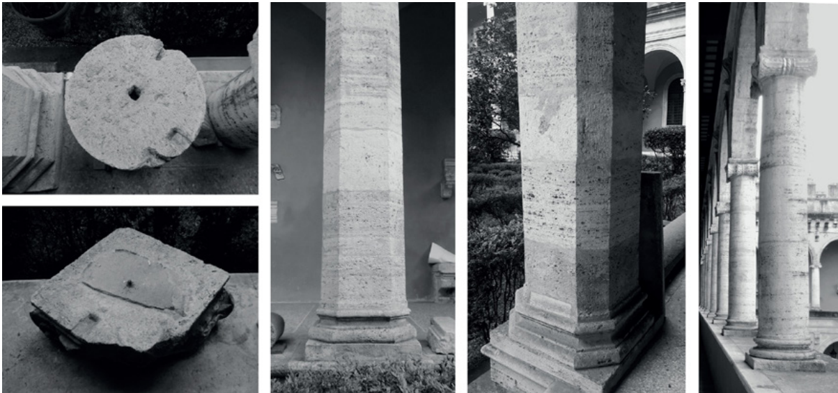
Figure 31a-e. I travertini dell'attuale chiostro del palazzetto. A sinistra, frammenti erratici del Viridarium non utilizzati, dove sono visibili i fori per l'imperniamento; al centro e a destra, pilastri e colonne delle arcate, dove sono visibili i segni di giunzione dei rocchi di cui sono composti e le reintegrazioni materiche (foto R. Finocchiaro, 2021).
