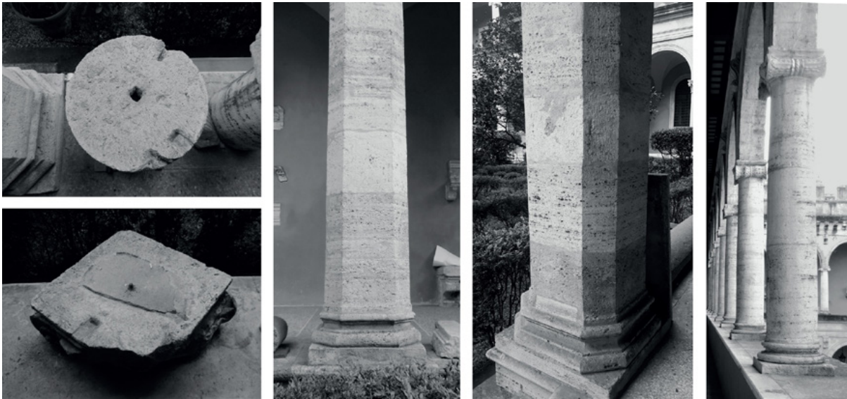
Figure 31a-e. I travertini dell'attuale chiostro del palazzetto. A sinistra, frammenti erratici del Viridarium non utilizzati, dove sono visibili i fori per l'imperniamento; al centro e a destra, pilastri e colonne delle arcate, dove sono visibili i segni di giunzione dei rocchi di cui sono composti e le reintegrazioni materiche (foto R. Finocchiaro, 2021).
