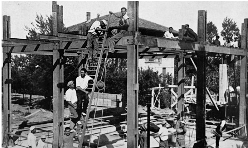
Fig. 1 Re-assembly of the metallic structure of the “abitazione tipica a struttura di acciaio”, set up in the V Milan-Triennale in 1933, as the “Torre Novecento” in Riccione, 1934. Quadrante , 1934.
