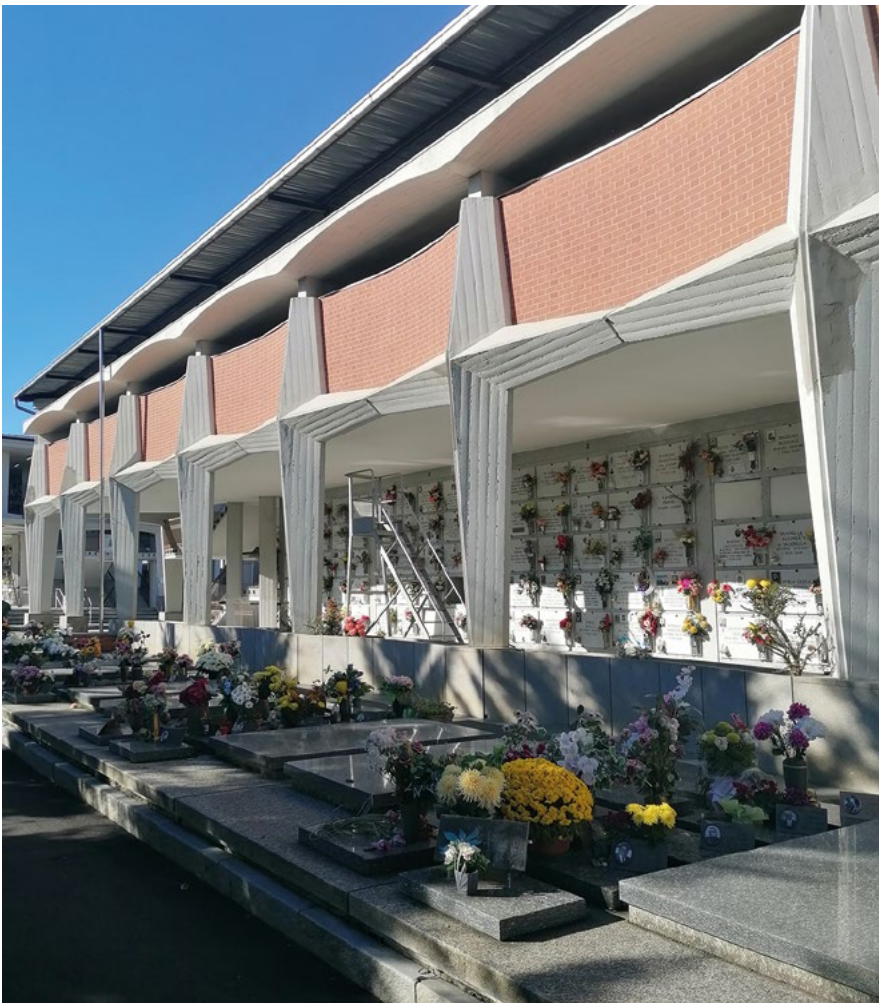
Fig. 1 - Cimitero Monumentale settima ampliamento, complessi loculi a croce (N. Paganelli, 2023).
