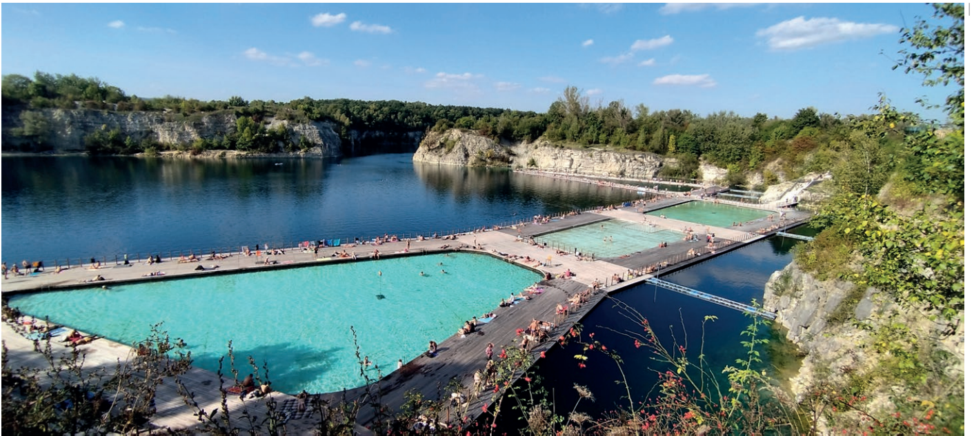
07 | Parco e piscina Zakrzówek, Cracovia, Polonia – Elena Dziopak 2024 Bacino artificiale quasi nel centro di Cracovia, creato dopo l'allagamento di una vecchia cava di calcare e dopo la rivitalizzazione trasformato in un parco paesaggistico unico di oltre 50 ettari Zakrzówek park and swimming pool, Krakow, Poland – Elena Dziopak 2024 Artificial reservoir almost in the Krakow 's centre, created after flooding an old limestone quarry and after revitalisation transformed into unique landscape park of over 50 hectares
