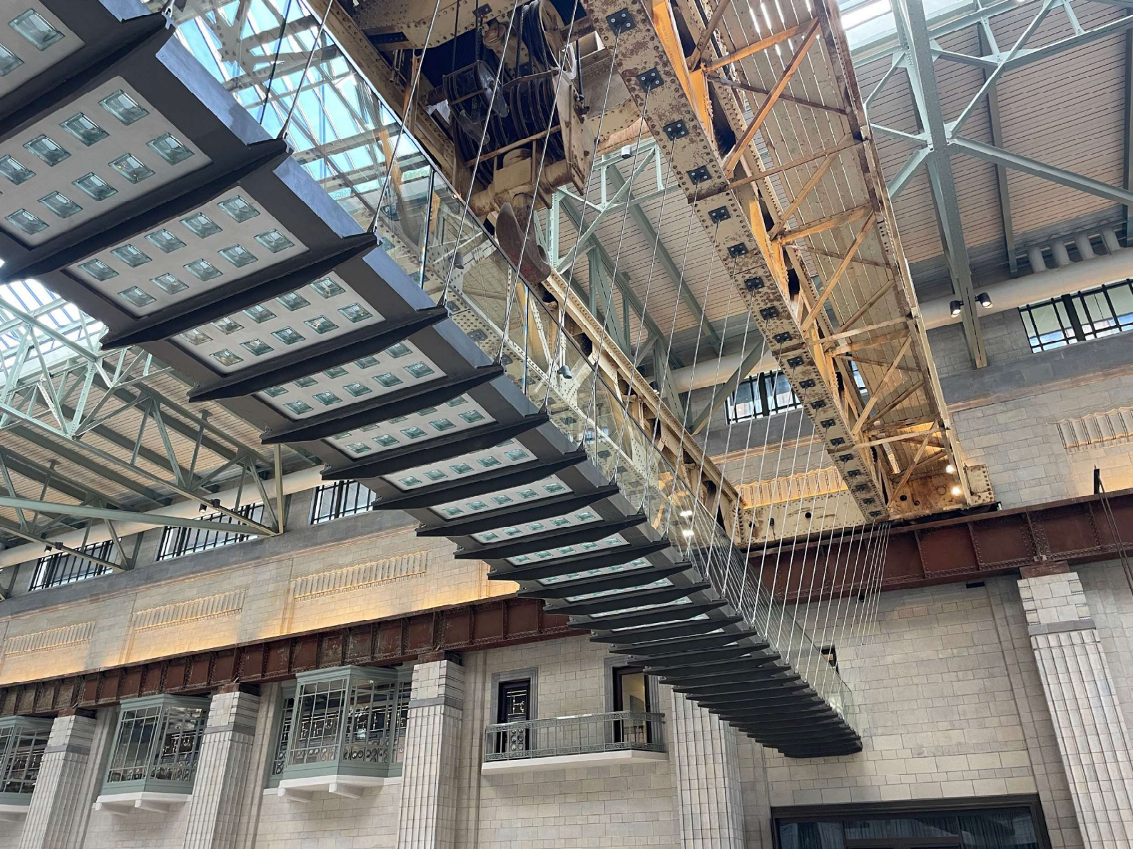
4 La struttura e l'apparato decorativo della Turbine Hall A in stile Art Déco.
