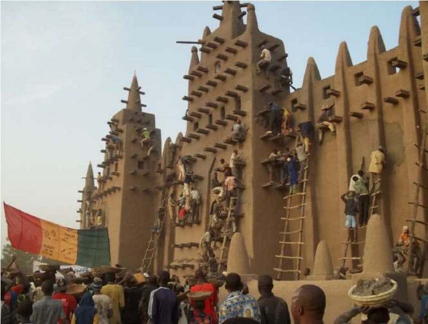
Rintonacatura della moschea in terra di Djenné, Mali, da parte della comunità locale, nel 2012 / Replastering of Djenne, Mali, Great Mosque by the local community in 2012
