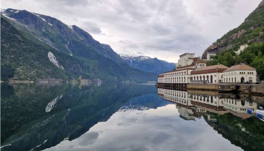
La ex-centrale idroelettrica di Tyssø I, nella contea del Vestland (Norvegia). Oggi ospita il Kraftmuseet (Museo Norvegese dell'Idroelettrico e dell'Industria), luglio 2024 / The former hydroelectric power station in Tyssø I, Vestland County, Norway. Today, Kraftmuseet (Norwegian Museum of Hydropower and Industry), July 2024
