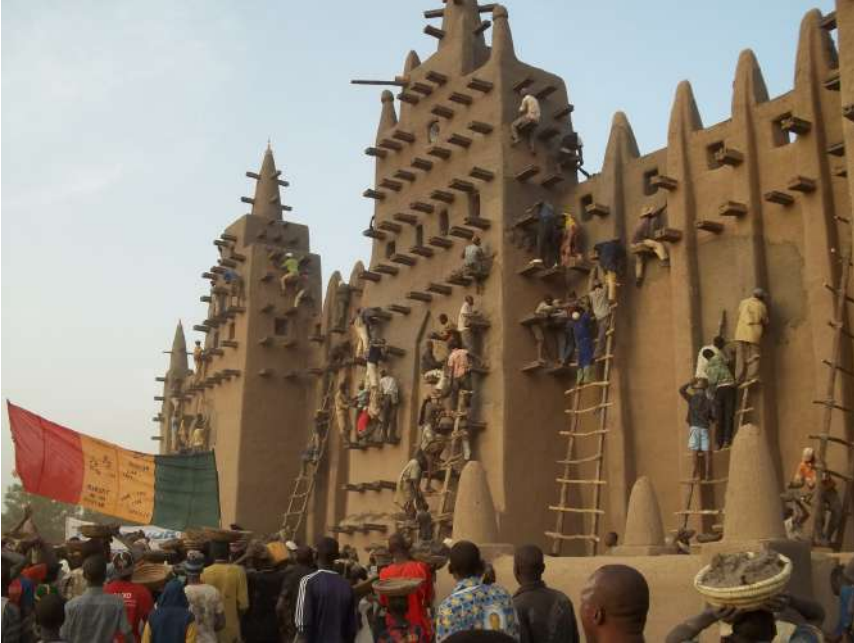
Rintonacatura della moschea in terra di Djenné, Mali, da parte della comunità locale, nel 2012 / Replastering of Djenné, Mali, Great Mosque by the local community in 2012
