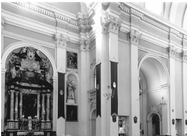
Fig. 13. Ferrara. Veduta interna del transetto della chiesa teatina. Si nota al centro l'espedito della campata più breve utilizzata per portare all'interno della navata una luce radente la cappella del transetto (Catalogo Generale dei Beni Culturali e archivio fotografico della Soprintendenza Archeologia, Belle Arti e Paesaggio della città metropolitana di Bologna e per le provincie di Modena, Reggio Emilia e Ferrara).
