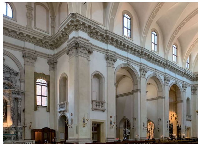
Fig. 14. Rovigo. Duomo, veduta interna con evidenziate le tre cappelle lungo l'aula e il pilone della cupola con le aperture del livello superiore tamponate, stato attuale.
