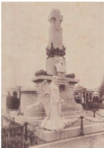
Fig. 17_Modello in gesso, fotografato presso la bottega Musso e Papotti, preliminare alla realizzazione della tomba Tealdi nel cimitero monumentale di Torino, 1893. Negativo b/n su lastra di vetro, MC 10.
