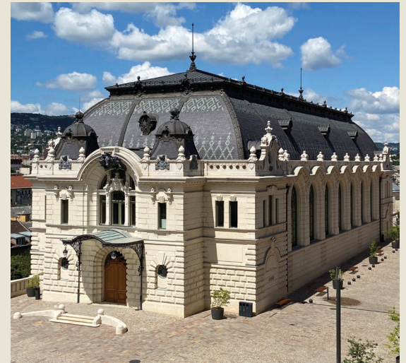
Fig. 4 – Budapest, il maneggio del Palazzo Reale (Alajos Hauszmann, 1902), demolito nel 1950 e ricostruito nel 2020, foto di Paolo Cornaglia, 2022.
