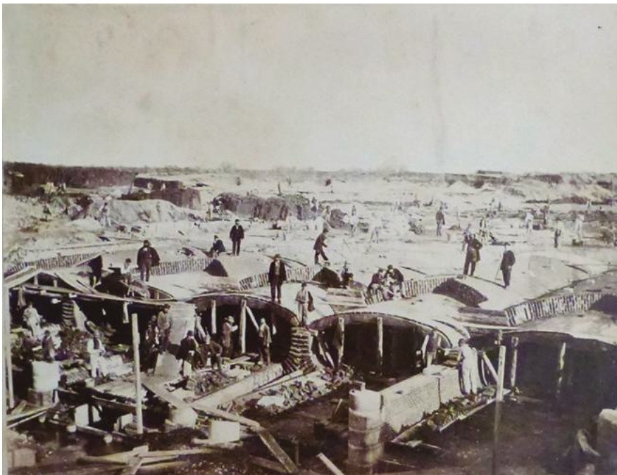
Figura 4: Sifón bajo el río Sesia: la obra [Ministero delle Finanze. Direzione Generale del Demanio. Canale Cavour e Diramatori, Canale Cavour, in Archivio Storico delle Acque e delle Terre Irrigue (Novara)]
