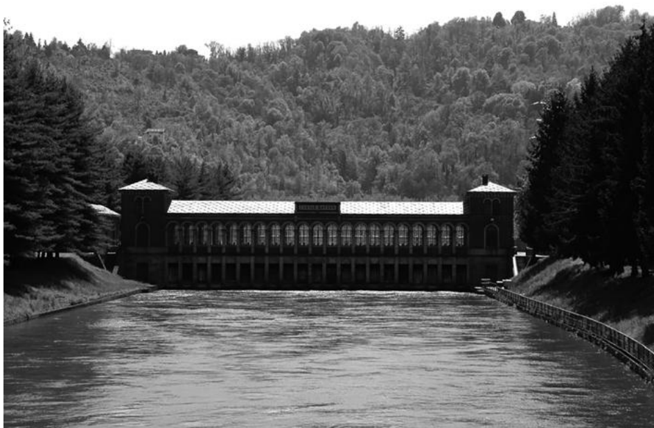
Figura. 1: Canal Cavour. Edificio toma de agua del Po. Chivasso (Turín) (C. Ocelli)
