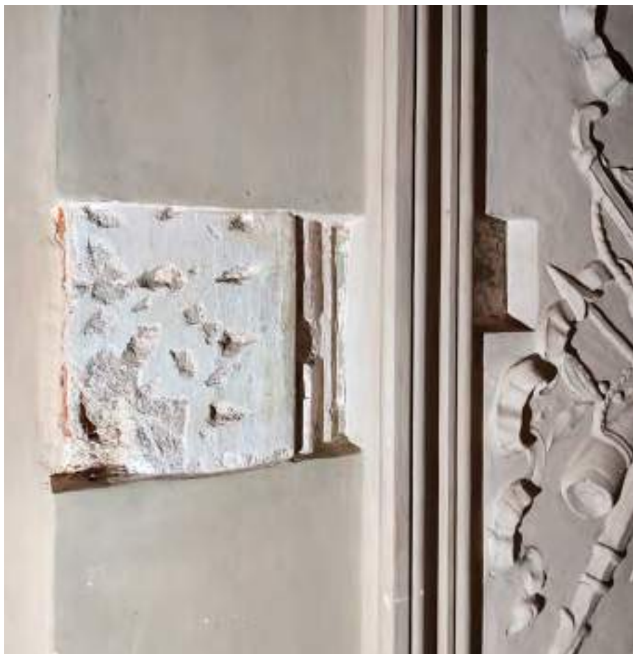
Fig. 8_Dettaglio del saggio realizzato durante il restauro dello scalone che mostra la decorazione settecentesca oblitterata. Fotografia E. Dutto, 2024. Su gentile concessione di Francesco Alberti La Marmora.
