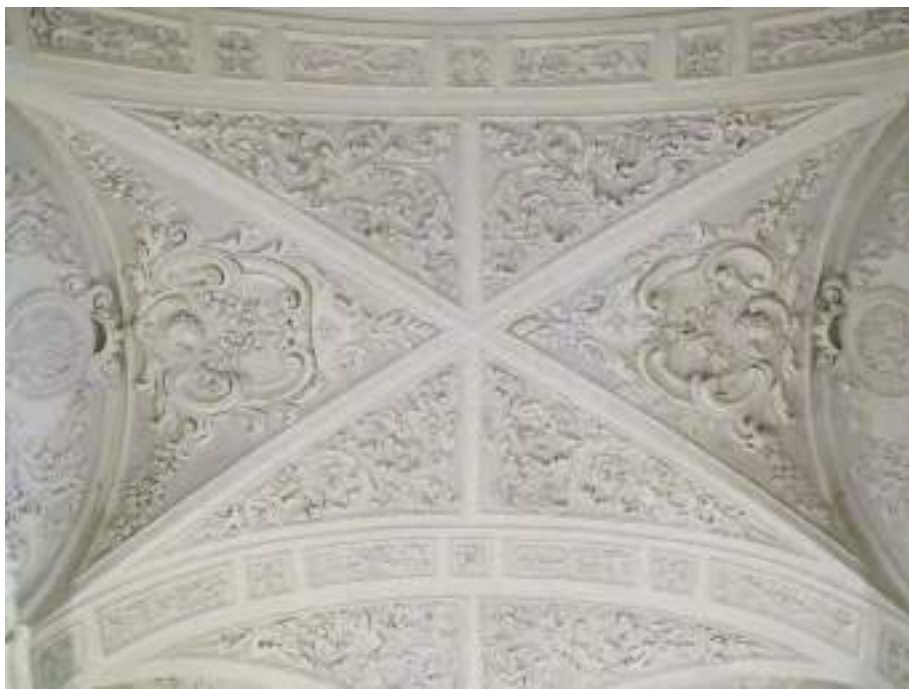
Fig. 3_Torino, Castello del Valentino, cappella, decorazione in stucco bianco delle volte a crociera che coprono l'ambiente (foto Maria Vittoria Cattaneo).
