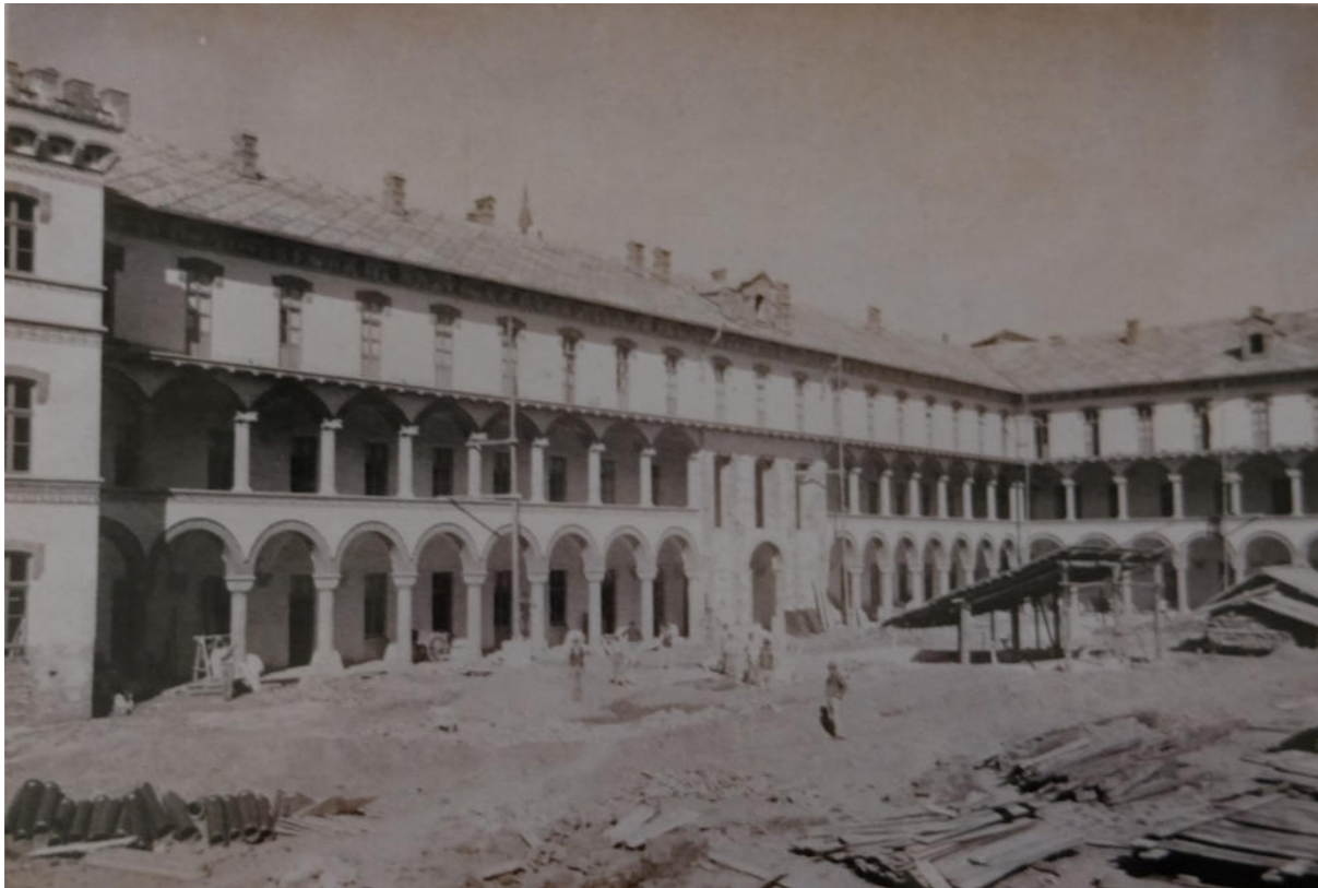
Fig. 5 - Fotografia del cantiere. Si noti, a metà del corpo principale, il diverso andamento del porticato, con un fornice a pian terreno che avrebbe dovuto fungere da ingresso alla chiesa, poi realizzata diversamente in un secondo momento (ASCP, “Città di Pinerolo, Sviluppo edilizio e industriale, 1848-1924”).
