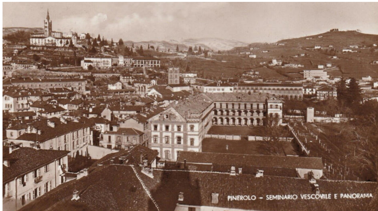
Fig. 7 - Cartolina della prima metà del Novecento raffigurante il Seminario con il muro di divisione della corte. Si noti posteriormente il lembo di terreno a quota differente rispetto al piano di calpestio interno al complesso (collezione privata).
