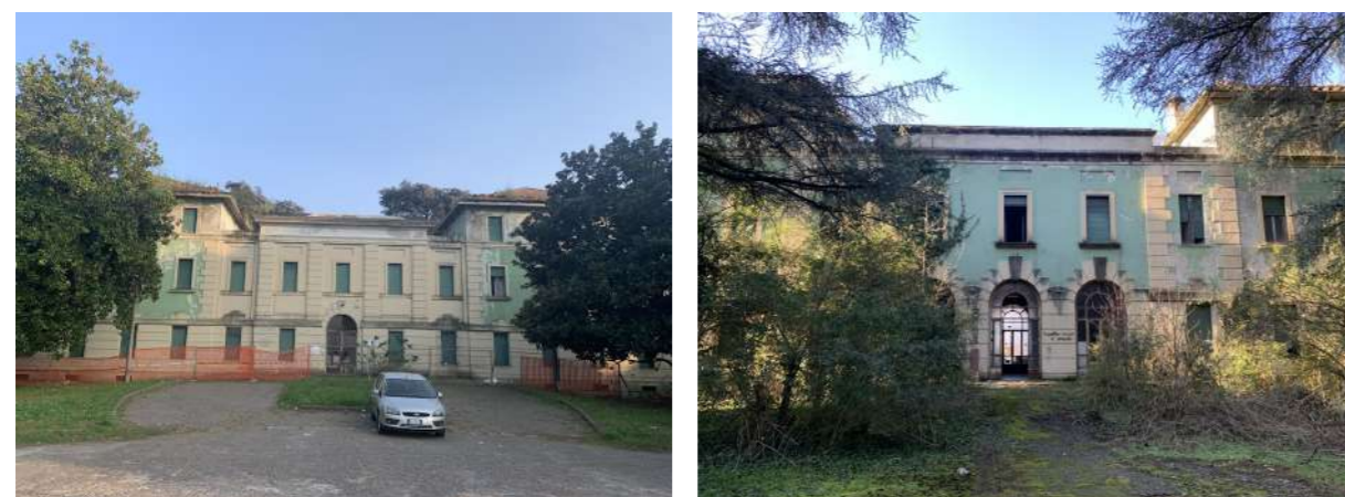
Figg. 4-5 - Padiglione di ingresso (Dabbene, 2025).
