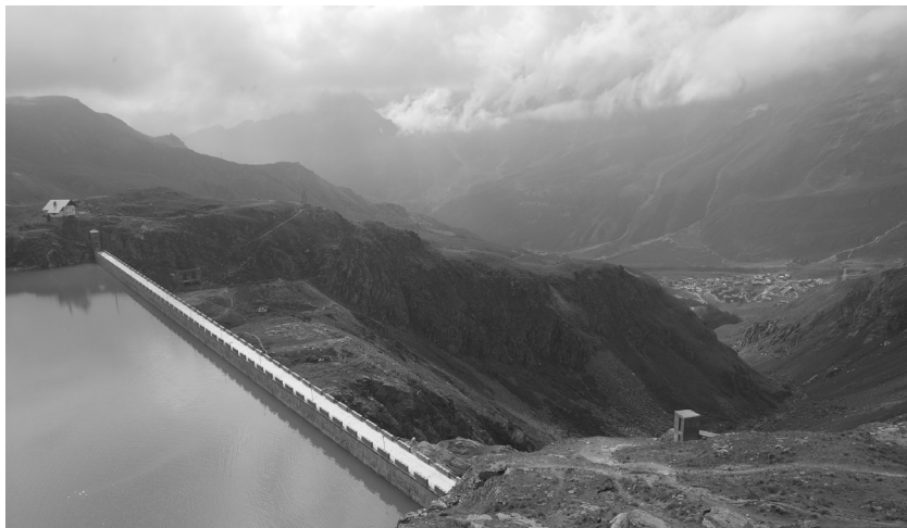
Fig. 04. Diga del Goillet, Valtournenche Valtournenche (AO), 1939-1947, collaudo 1952. Capacità utile di invaso: 11.159.000 m 3 ; tipologia della struttura: a gravità in massiccia. (© Fotografia Studio Publica, 2017)
