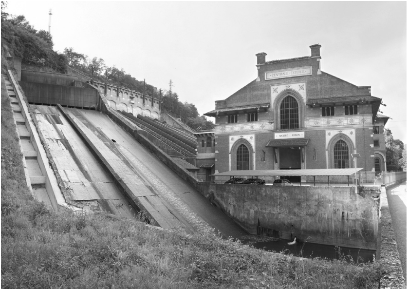
Fig. 03. Centrale idroelettrica Esterle, Porto d'Adda di Cornate d'Adda (MB), 1906-1914. Centrale attiva. (© Fotografia Studio Publica, 2017)
