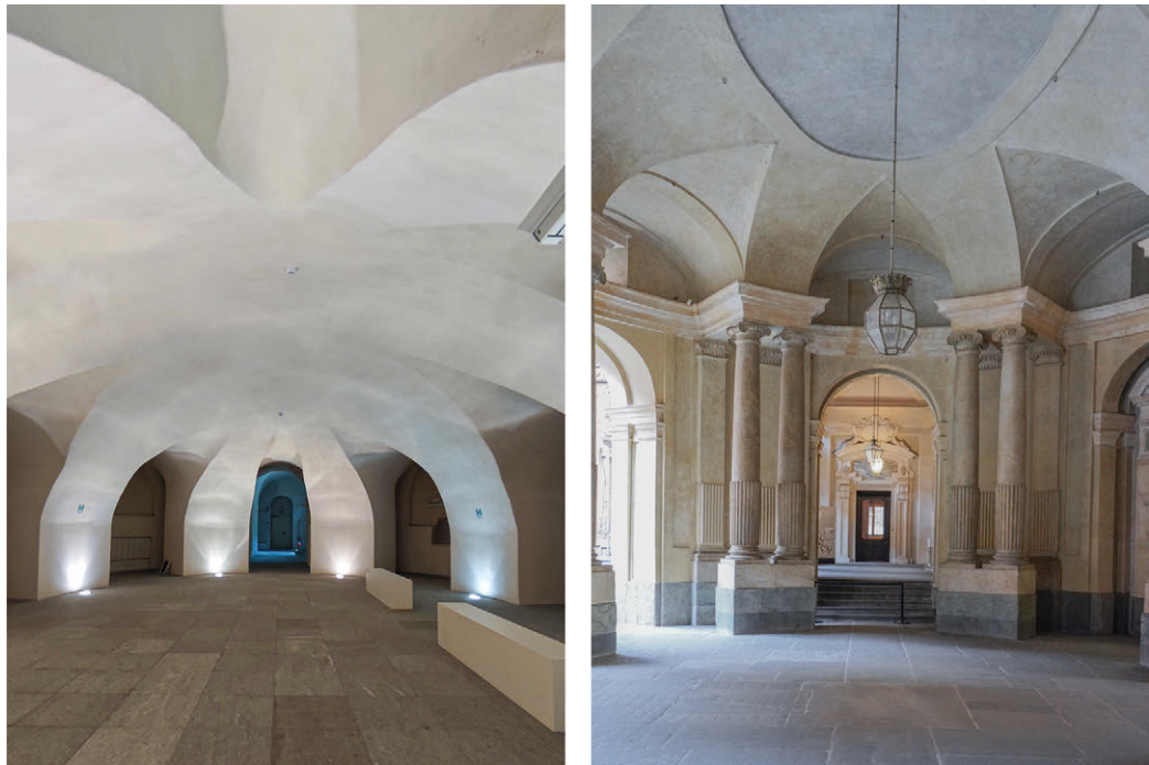
Fig. 7. A sinistra: Sala del corpo centrale al piano interrato, 2024, Palazzo Carignano; a destra: atrio, 2024, Palazzo Carignano. (fotografie dell'autore).
