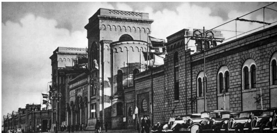
Figura 8 | Ingresso Monumentale, immagine storica.
