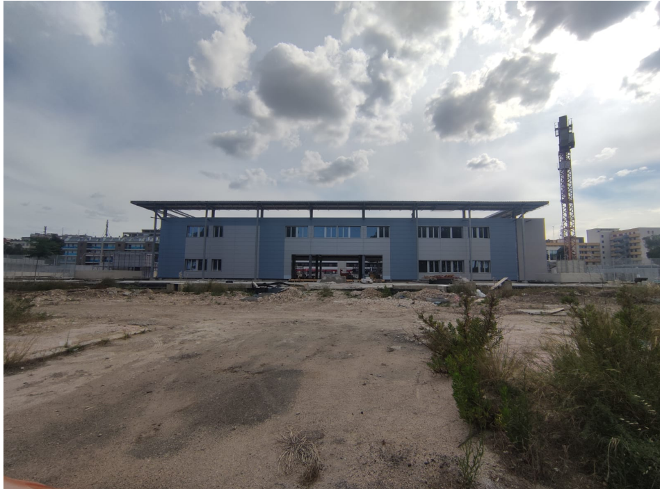
Figura 11 | Cantiere nuovi uffici.
