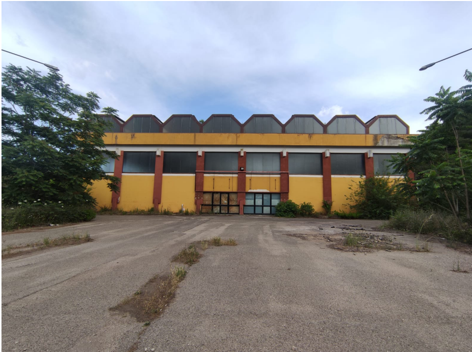
Figura 9 | Padiglione edificato durante gli anni '70.
