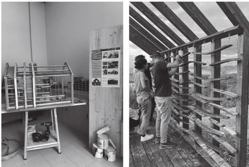
Figura 5. Da doghe di botti dismesse a un belvedere tra le colline: modello tecnologico di studio (a sinistra) funzionale alla realizzazione dell'intervento (a destra).
