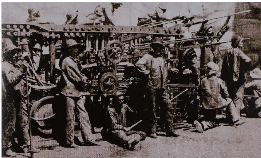
Traforo del Frejus, Operai in posa davanti alla perforatrice. P.L. Bassignana, A. Zanini (a cura di), Macchine, invenzioni, scoperte. Scienza e Tecnica a Torino e in Piemonte tra '800 e '900 , Prato 2012, p. 33.
