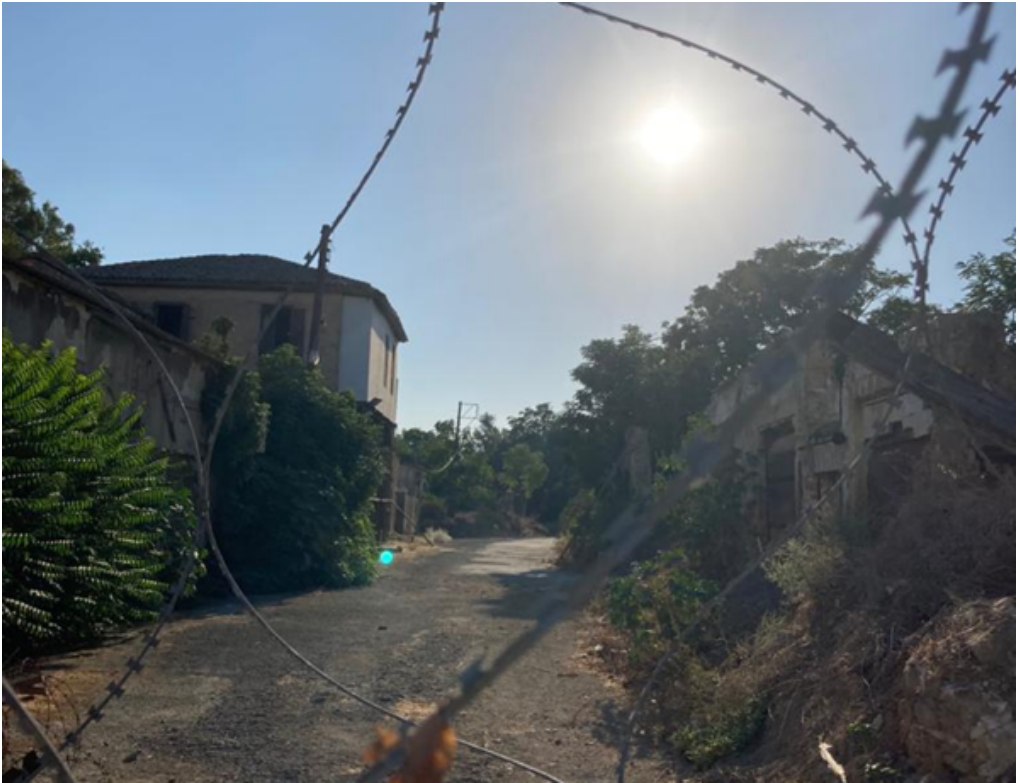
4: Abbandono e macerie sulla vecchia Ermou Street
