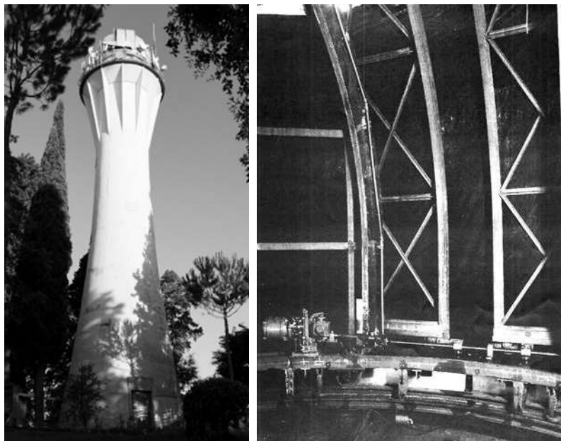
Fig. 13. Torre solare dell'Osservatorio Astronomico di Roma Monte Mario, 1958: vista esterna della torre e immagine di cantiere relativa al montaggio della cupola e ai meccanismi di movimentazione della cupola (Cimino 1964; Archivio A. Bombelli).
