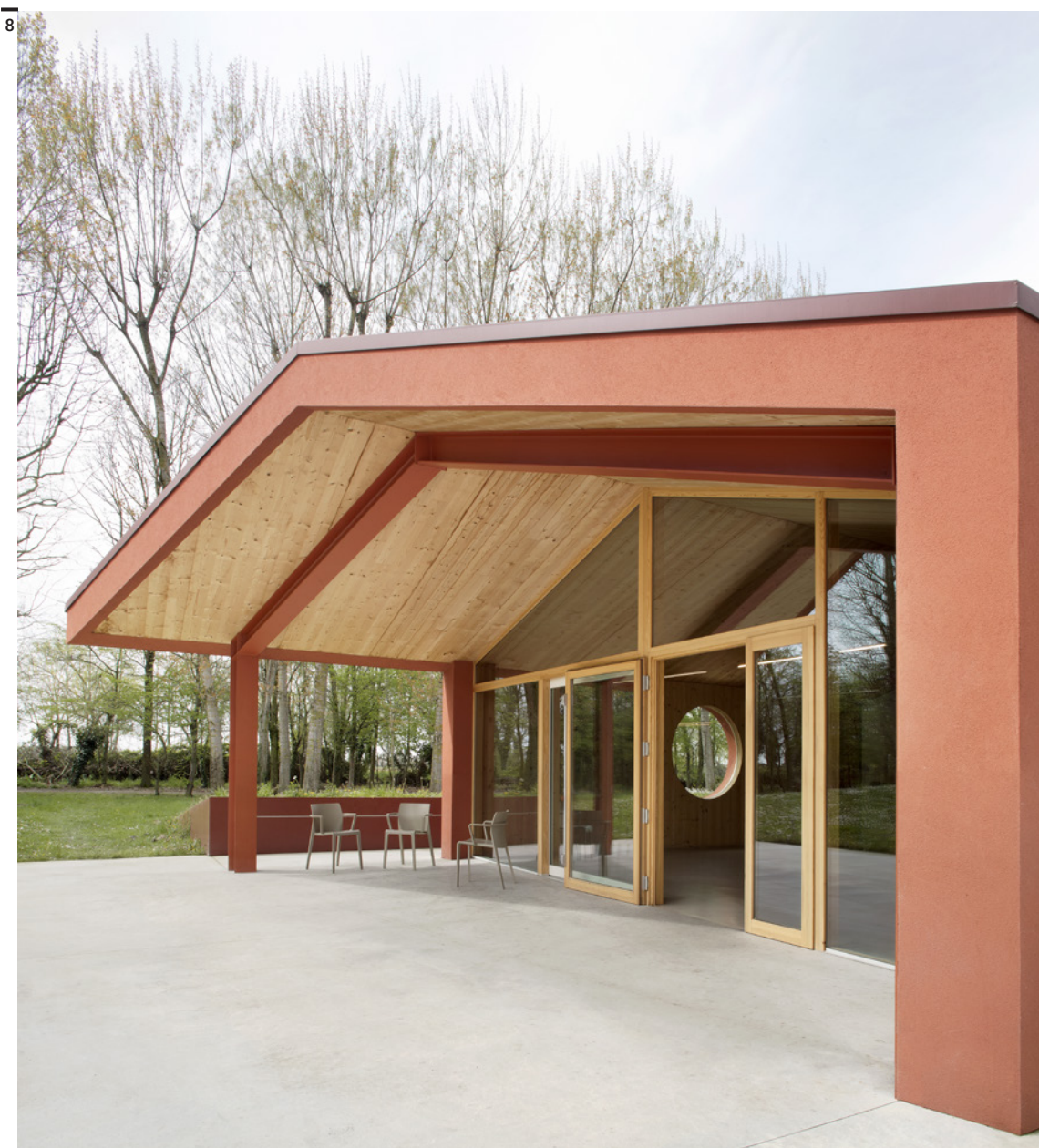
Fig. 6 Casa 4, Magnago, Milano, LCA architetti, 2016.
