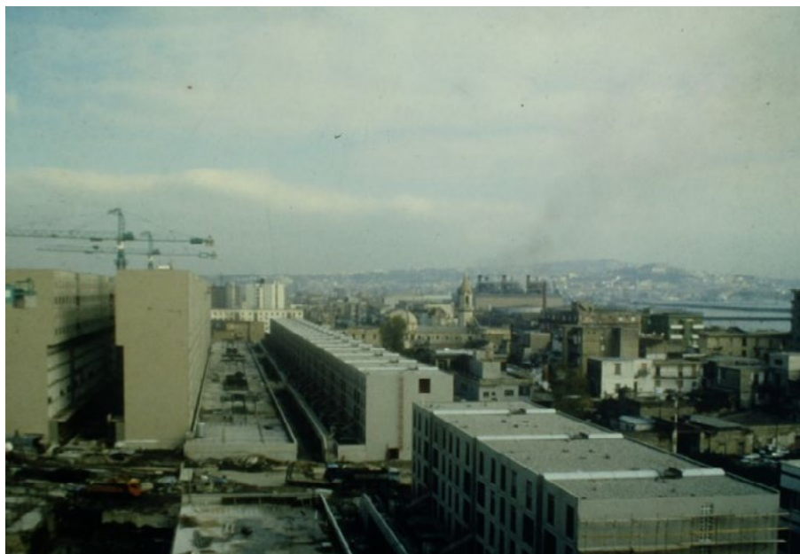
3: Una fotografia aerea del cantiere mostra la fase di montaggio dei moduli prefabbricati, 1975 circa (datazione incerta).Fonte: Napoli. Comune di Napoli. Centro Documentazione UrbaNA presso il Servizio di pianificazione urbanistica generale e beni comuni. Archivio Fotografico, F. 17.
