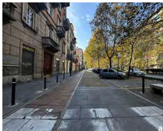
Fig. 18/ Torino, Corso Francia, sezione stradale, dove l'intero spazio accessibile è privo di dislivelli, I marciapiedi in prossimità dei fronti edilizi sono separati dalle corsie di marcia mediante la pista ciclabile. All'interno della sezione stradale sono stati inseriti anche degli elementi verdi che rendono il viale alberato molto piacevole.
