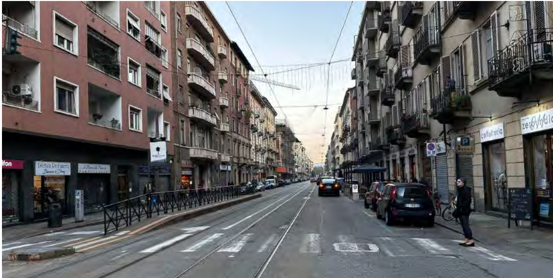
Fig. 24/ Torino, Quartiere San Donato, Via Luigi Cibrario. Immagine di una sezione stradale, contesto 1, dove è possibile rilevare la banchina per la fermata del trasporto pubblico; la corsia preferenziale per il trasporto pubblico; l'area per la sosta lungo la strada solo dove non è presente la fermata dei mezzi pubblici; il marciapiede pedonale da ambo i lati; l'attraversamento pedonale garantito dalle strisce pedonali a pavimento. (Foto dell'autrice, novembre 2024).
