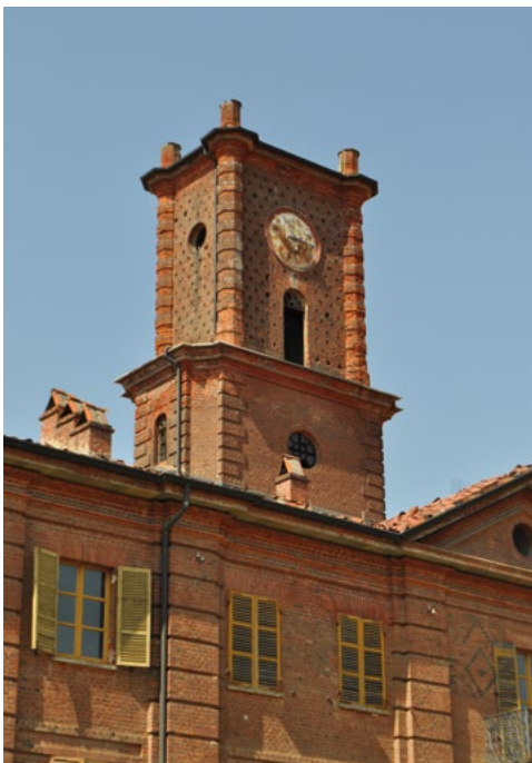
Fig. 4 – Il "pinnacolo" ancora in opera, intorno al 1980 (facciata verso il parco); e a terra, nel 2021.
