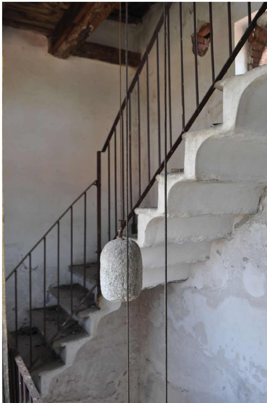
Fig. 9 – Rampe superiori della scala e contrappeso dell'orologio. Sotto, rampe di scale a sbalzo antonelliane (ASTR, Archivio Franco Rosso).
