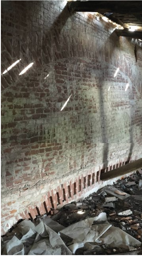
Fig. 7 - Archi di scarico nel muro trasversale alla base della torre nel sottotetto.
