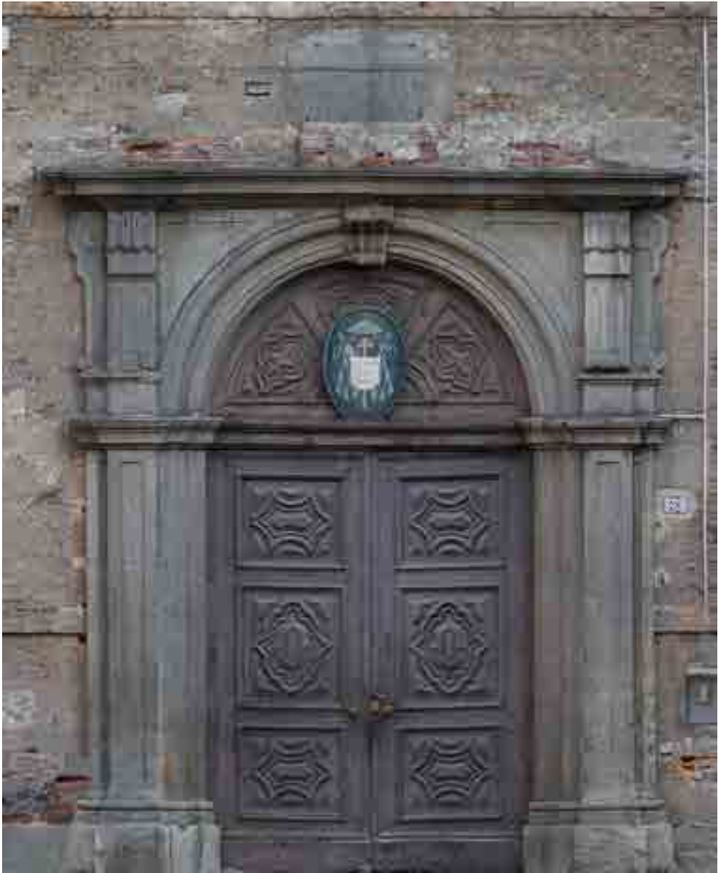
5: Vista frontale del portale ottenuta dal modello digitale ricostruito mediante l'impiego di tecniche fotogrammetriche: la rappresentazione mette in evidenza i caratteri architettonici e materici con qualità fotorealistica (elaborazione dell'autore, 2022).
