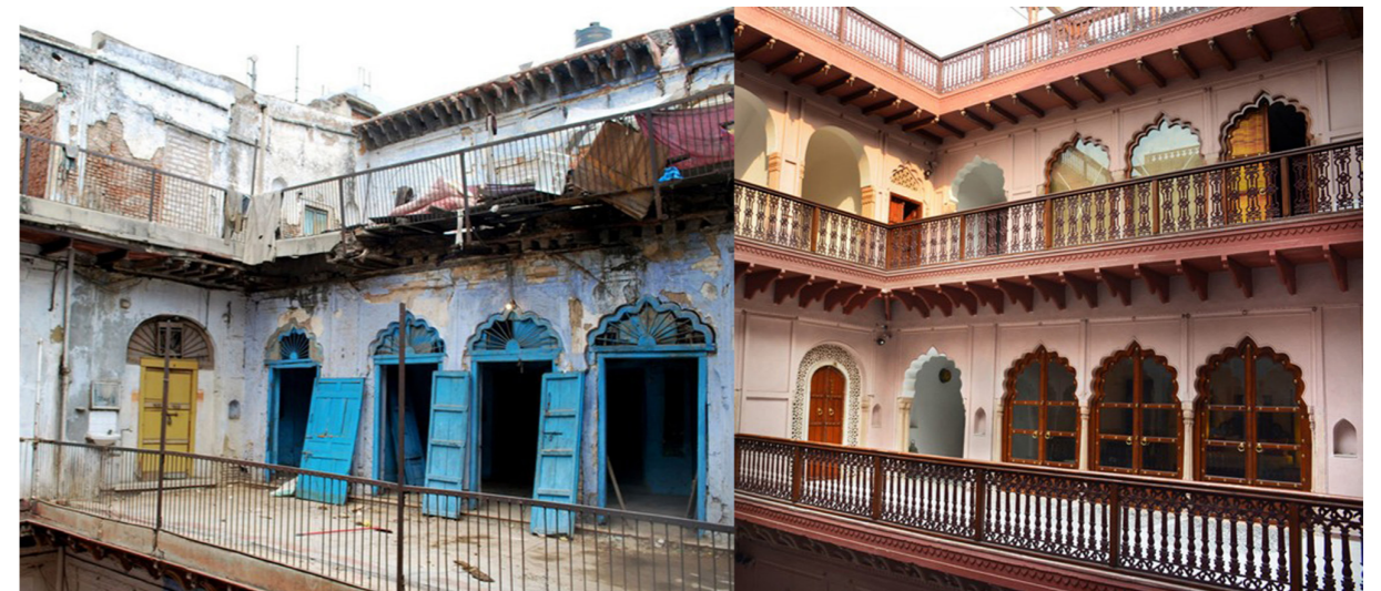
Fig. 4 - Haveli Dharampura, Shahjahanabad, prima e dopo l'intervento (crediti: Haveli Dharampura).
