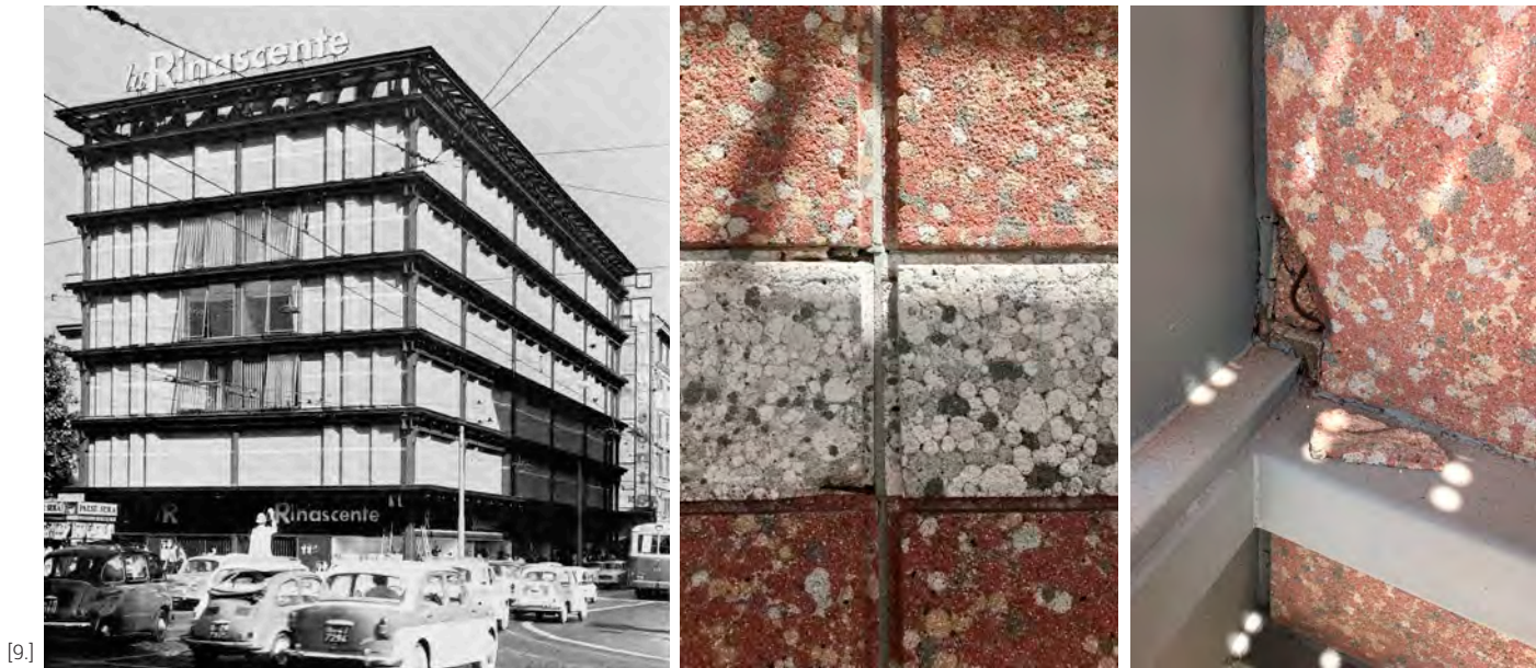
Fig. 9. Franco Albini e Franca Helg, La Rinascente di Roma, 1957-61. A sinistra un'immagine d'insieme (WERK 1962, 8). A destra due fotografie del rivestimento, scattate nel corso del recente intervento di restauro delle facciate (2021-2023).
