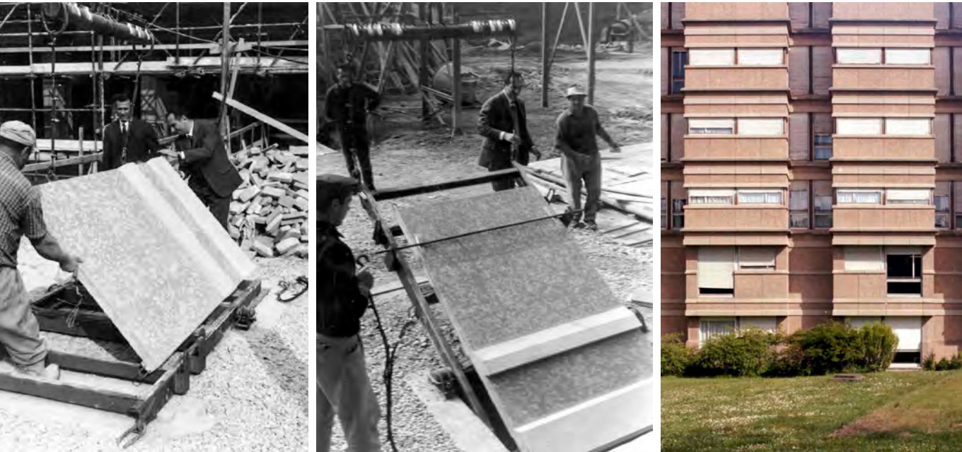
Fig. 12. Franco Albini e Franca Helg, Terme Zoja a Salsomaggiore, 1964-70. A sinistra, fasi di movimentazione dei pannelli di tamponamento in Silipol, in vista del sollevamento (Archivio Mariotti).
