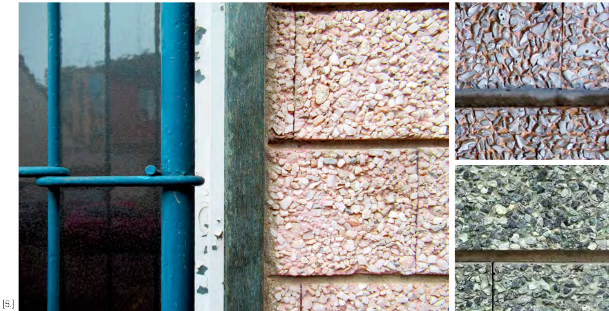
Fig. 5. Rivestimenti in Fulget prefabbricato, realizzati utilizzando diversi colori della malta di fondo (rosa, arancione, verde) e diversi mix di graniglia: a sinistra, in un edificio per abitazioni di Sergio Jaretti e Elio Luzi a Torino, via Pietro Cossa 52-7bis, 1958-59; a destra in alto, nell'atrio di una casa a Bergamo, via Mazzini 20; a destra in basso, in un edificio di Luigi Buffa a Torino, corso Duca degli Abruzzi 34 (fotografie dell'autrice).
