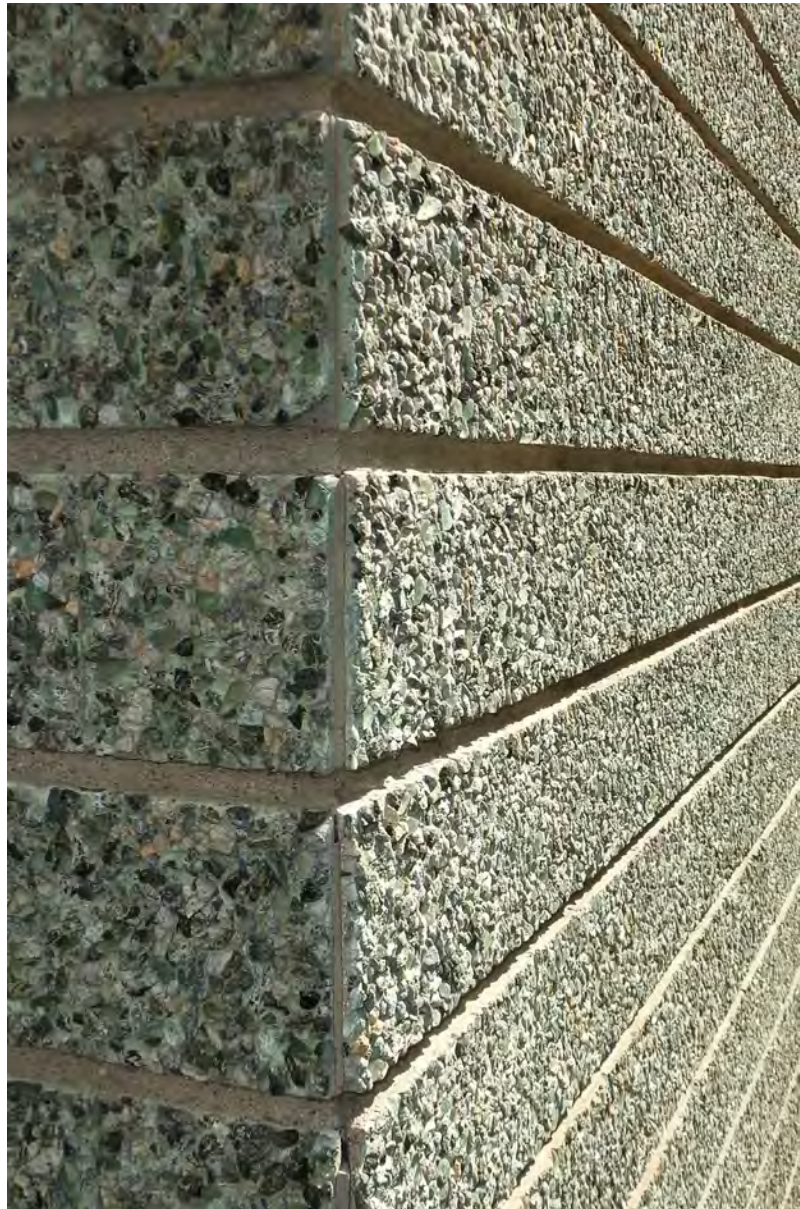
Fig. 16. Luigi Buffa, edificio residenziale, corso Duca degli Abruzzi, Torino (pubblicato in DOMUS 1952, 268). Un angolo dell'edificio con il rivestimento in Fulget prefabbricato (fotografia dell'autrice).
