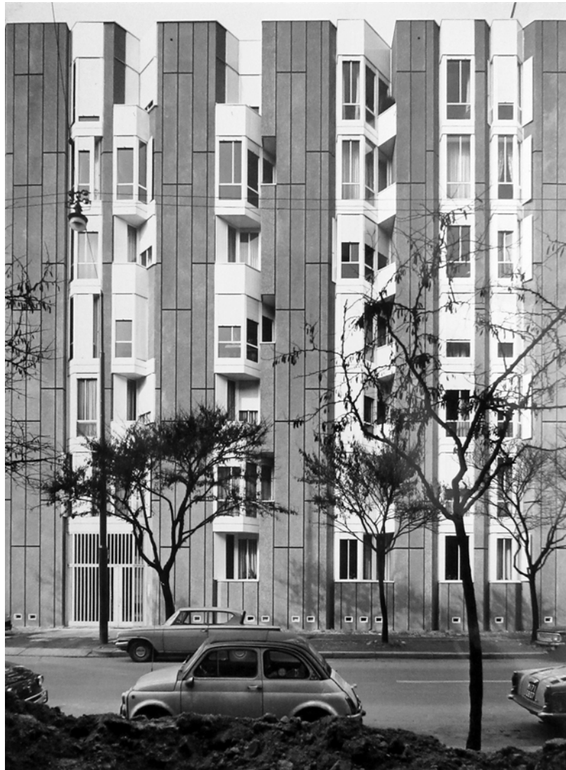
Fig. 14. Vittorio Gregotti, Lodovico Meneghetti e Giotto Stoppino, Edificio per la cooperativa "Un tetto" a Milano, via Desiderio da Settignano, 1964-68 (CASVA, Centro di Alti Studi sulle Arti Visive di Milano, Fondo Architetti Associati , fotografia di Aldo Ballo).
