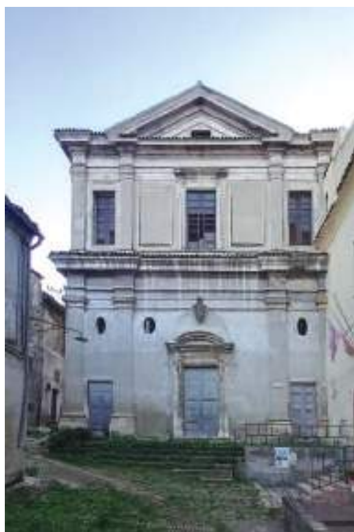
Fig. 11. Facciata principale della chiesa.
