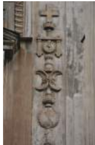
Figg. 17-18. Roma, Santa Maria del Priorato, particolare con gli ornati in stucco a fianco del portale prima e dopo l'intervento di restauro del 2017-2019 (foto G. Ferreri).
