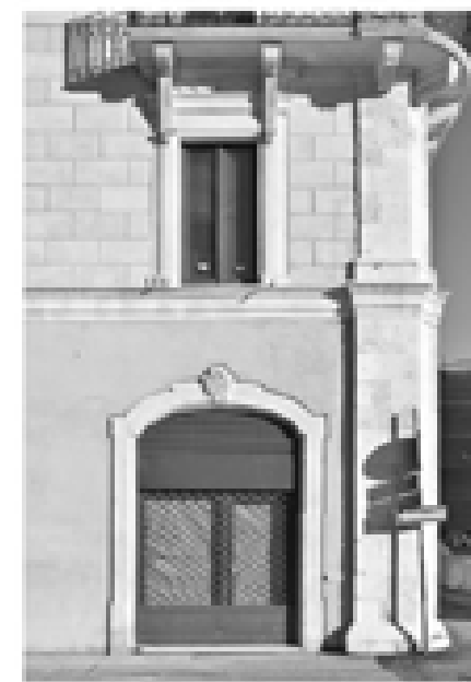
A sinistra: Quadro fessurativo facciata sul corso (el. Nardisarchitetti, L'Aquila 2014). A destra: Nuovo finto bugnato ad intonaco dopo gli interventi di restauro (ph. G. Mastrangelo, 2019).
