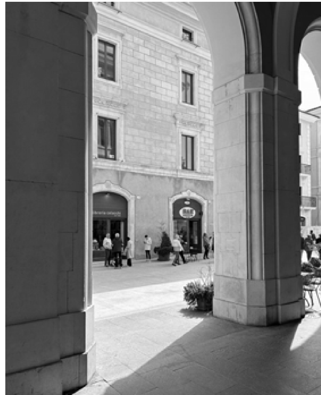
Scorcio sulla facciata restaurata dopo la pioggia. Il nuovo bugnato a intonaco reagisce in maniera naturale alla pioggia, assorbendo temporaneamente l'acqua e rilasciandola gradualmente fino a raggiungere nuovamente una colorazione più uniforme. Si configura come una superficie architettonica viva, percepita in maniera diversa a seconda dei punti di vista, le riflessioni e le condizioni atmosferiche (ph. G. Mastrangelo, 2024).
