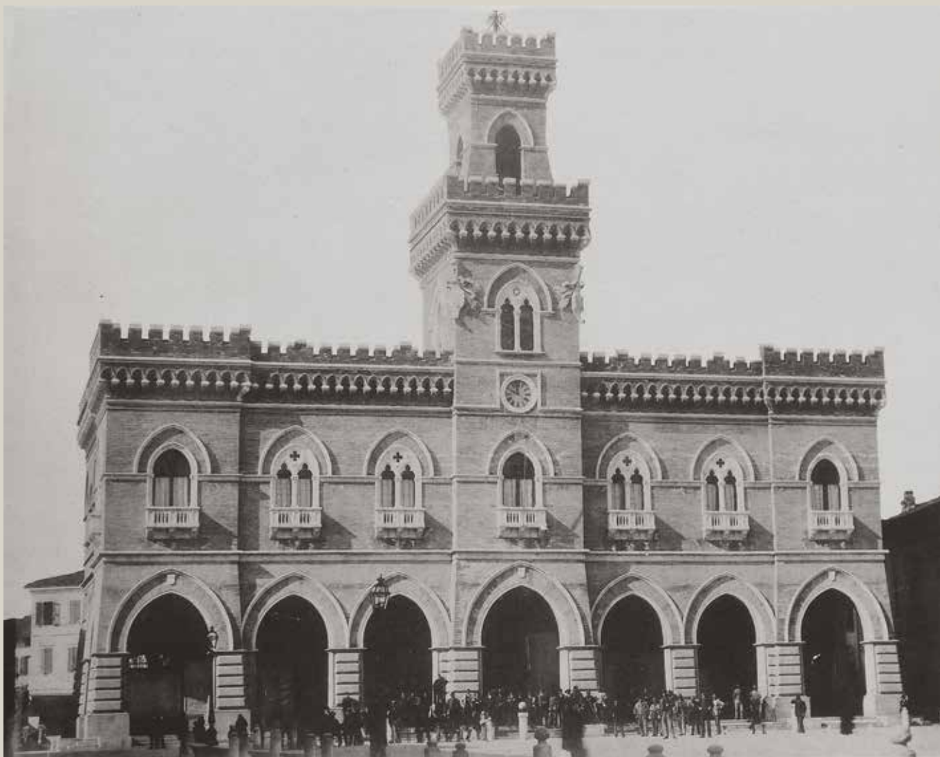
1. Casalmaggiore. Palazzo comunale: la facciata (Giacomo Misuraca, "Il nuovo Palazzo Municipale di Casalmaggiore", L'Edilizia Moderna. Periodico mensile di architettura pratica e costruzione , fasc. VII, luglio 1898, tav. XXX).
