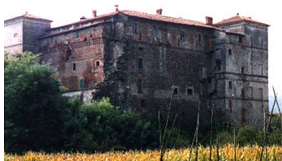
Castello di Saliceto (CN). Il restauro ha previsto la realizzazione della “Quarta torre” che ha reso accessibile il complesso. Progetto: Armellino & Poggio; foto: Fotobella.
